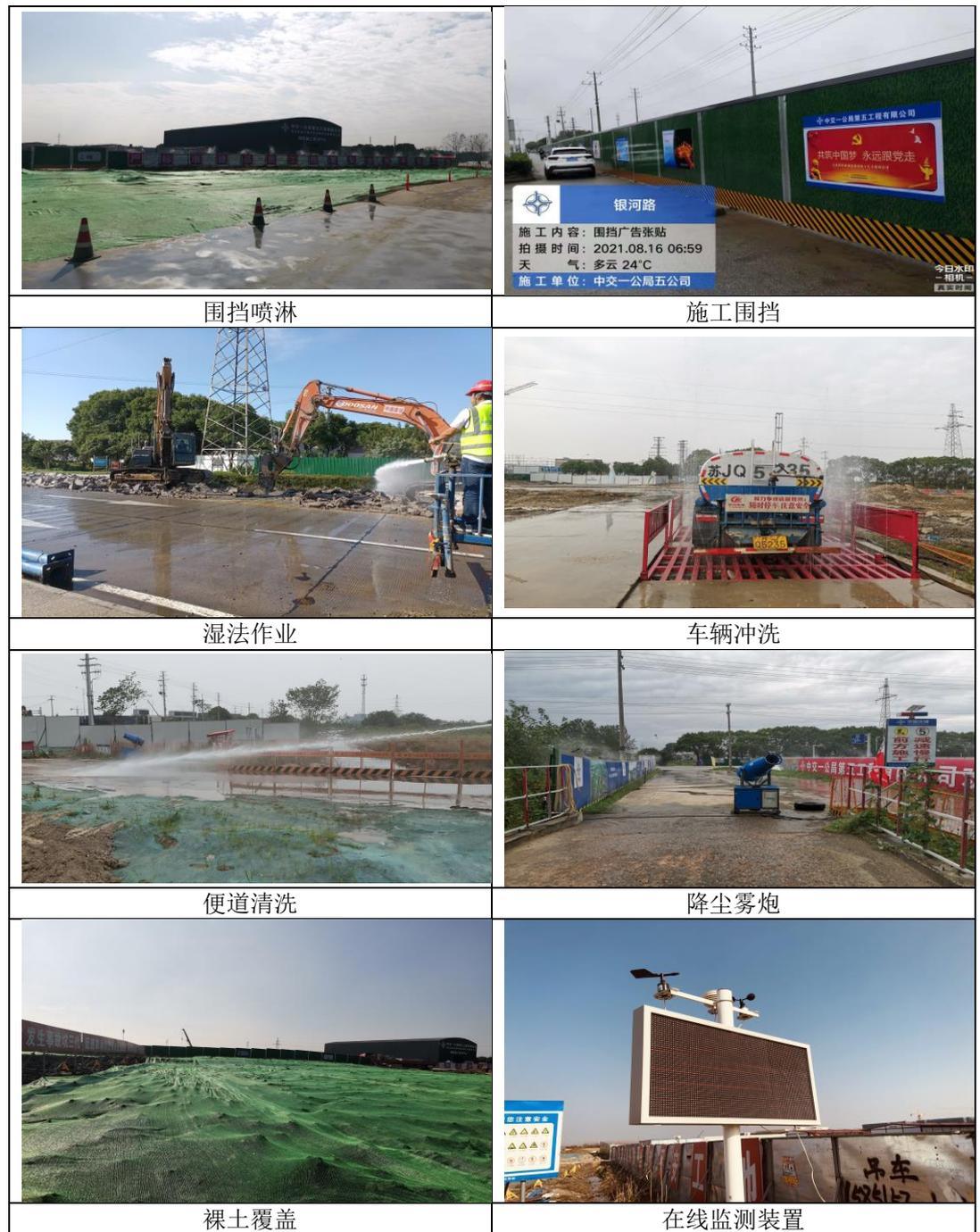
图 4-5 施工现场扬尘管控措施
