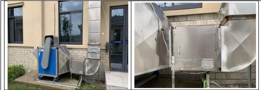
图 4-7 常熟高新区互通油烟净化装置
