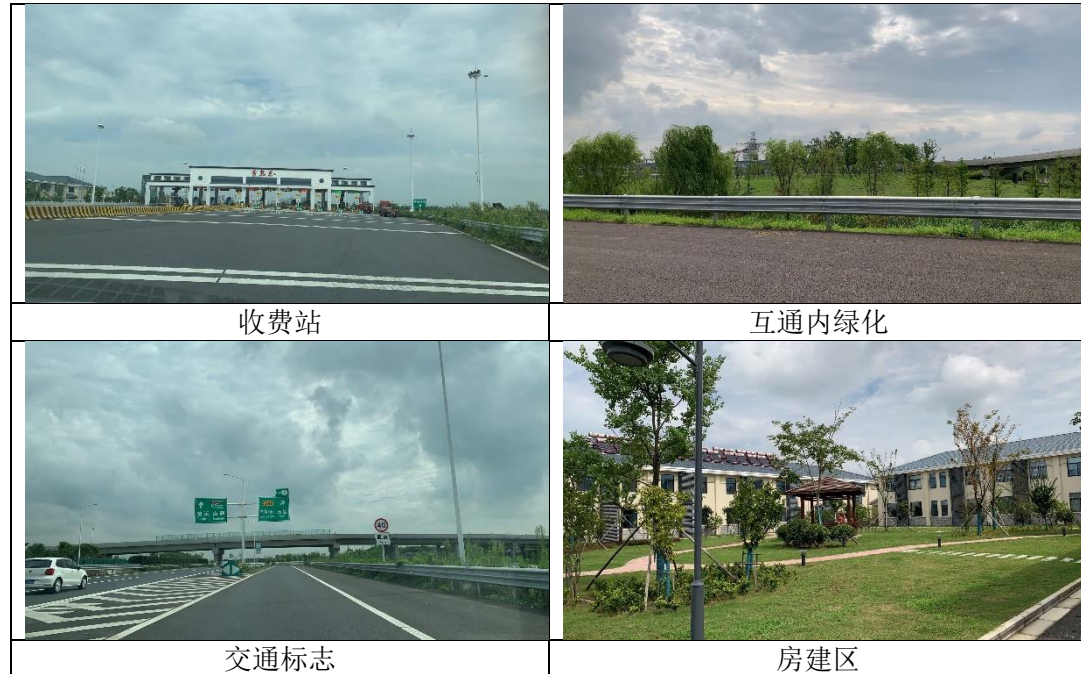
图 4-2 常台高速公路常熟东互通改扩建工程现状图
