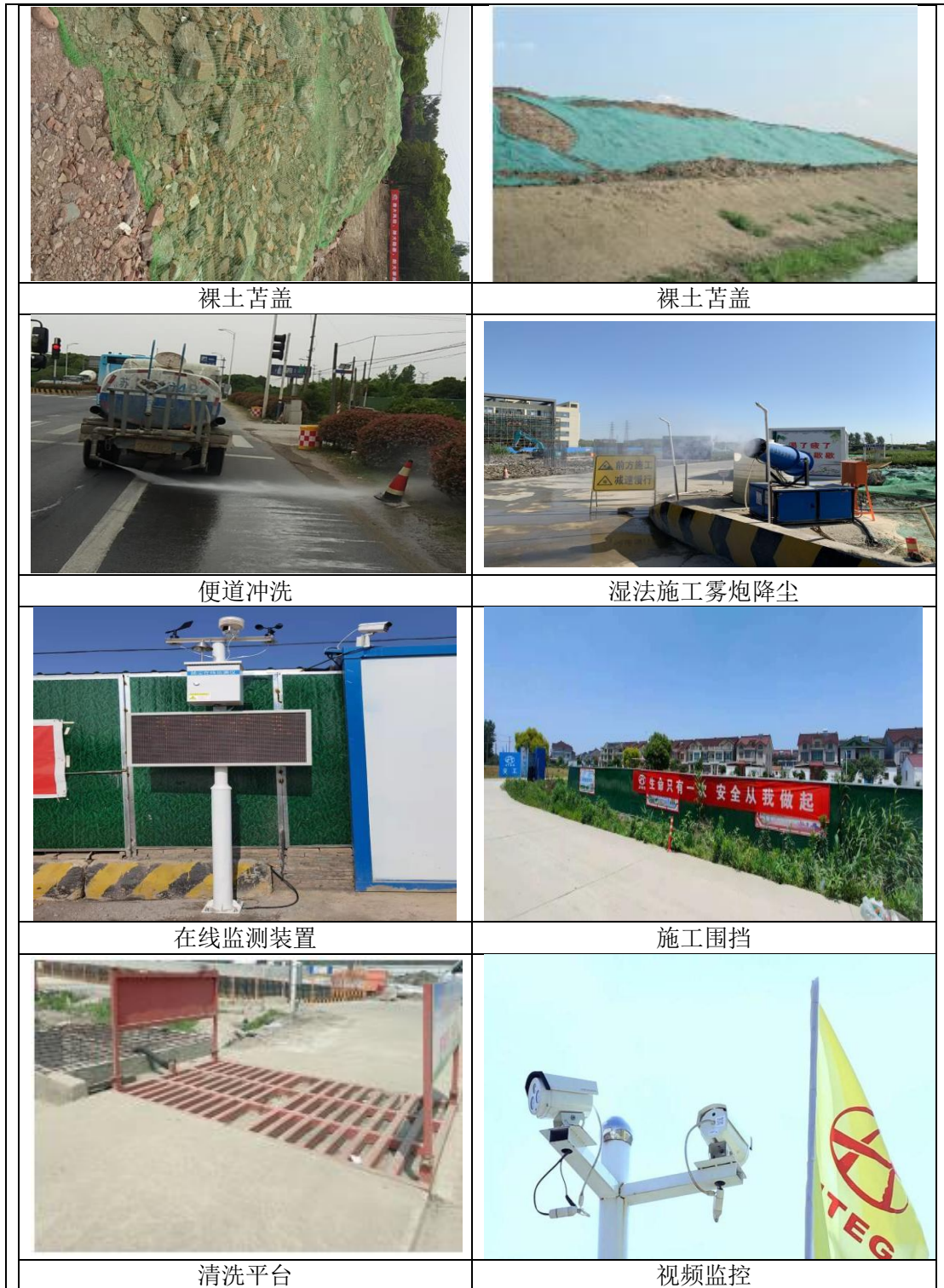
图 4-5 施工现场扬尘管控措施
