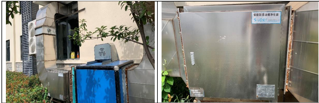
图 4-7 常熟东互通油烟净化装置
