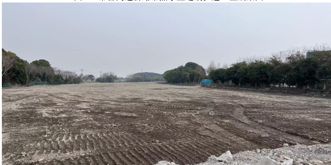
图 4-2 原东互通拆除现场
