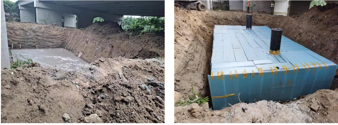
图8.3-2 应急事故池施工照片（施工后埋入地下不可见）
