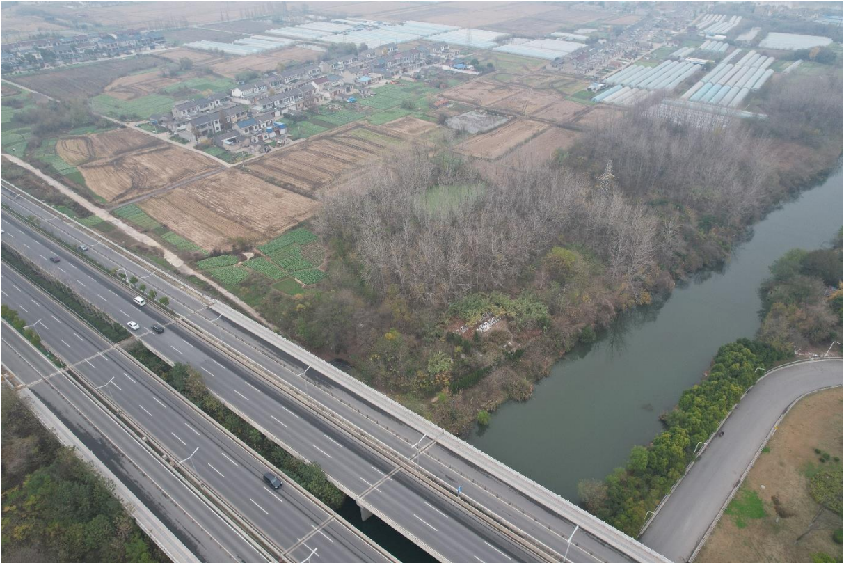
图6.2-1 南海村段项目部现状（已恢复）
