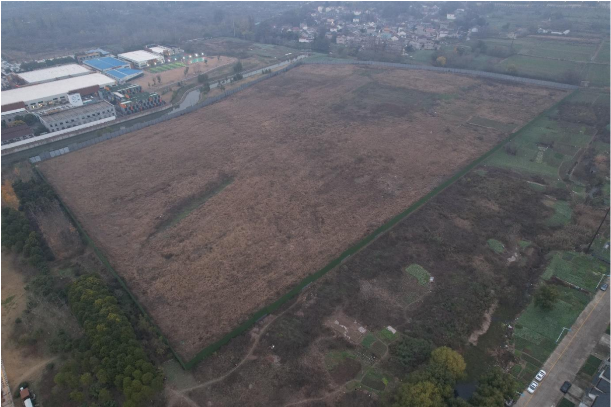
图6.2-3 中铁12局项目部现状（已恢复）
